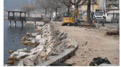
Garda: lavori di riqualificazione sul lungolago FOTO PECORA
