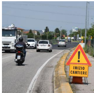
Il cantiere di via Sommacampagna si lavora di notte. FOTO PECORA
