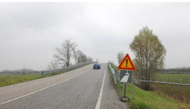
Il cavalcavia ferroviario di via Faro è stato messo in sicurezza. DIENNEFOTO
