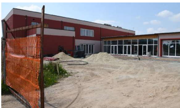
Il cantiere del nuovo polo scolastico a San Pietro di Lavagno FOTO PECORA
